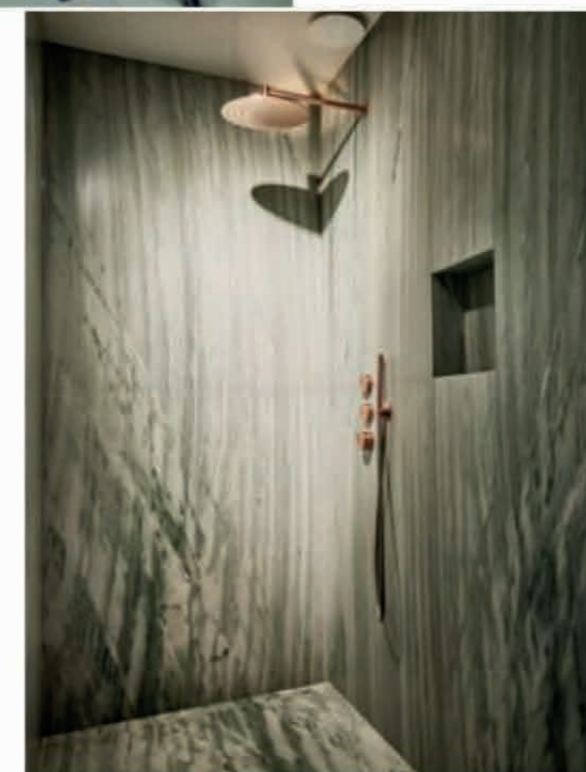
L'ambiente doccia realizzato in quarzite verde e resina colorata. La rubinetteria della zona bagno è in acciaio satinato e finitura rame
